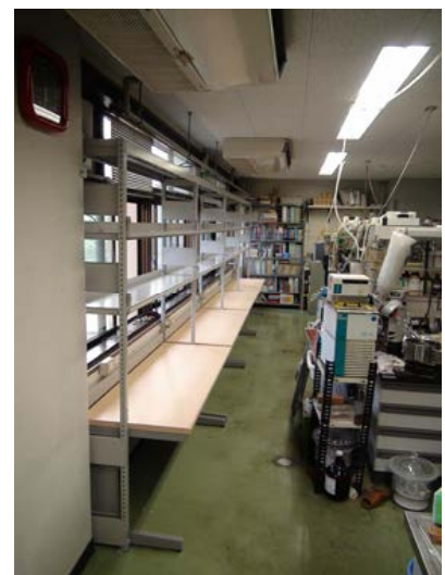
研究室の耐震対策。学生用の机（上段、入れ替え前）は全て転落防止用の棚がついて、壁に固定したもの（下段）に入れ替えた。
